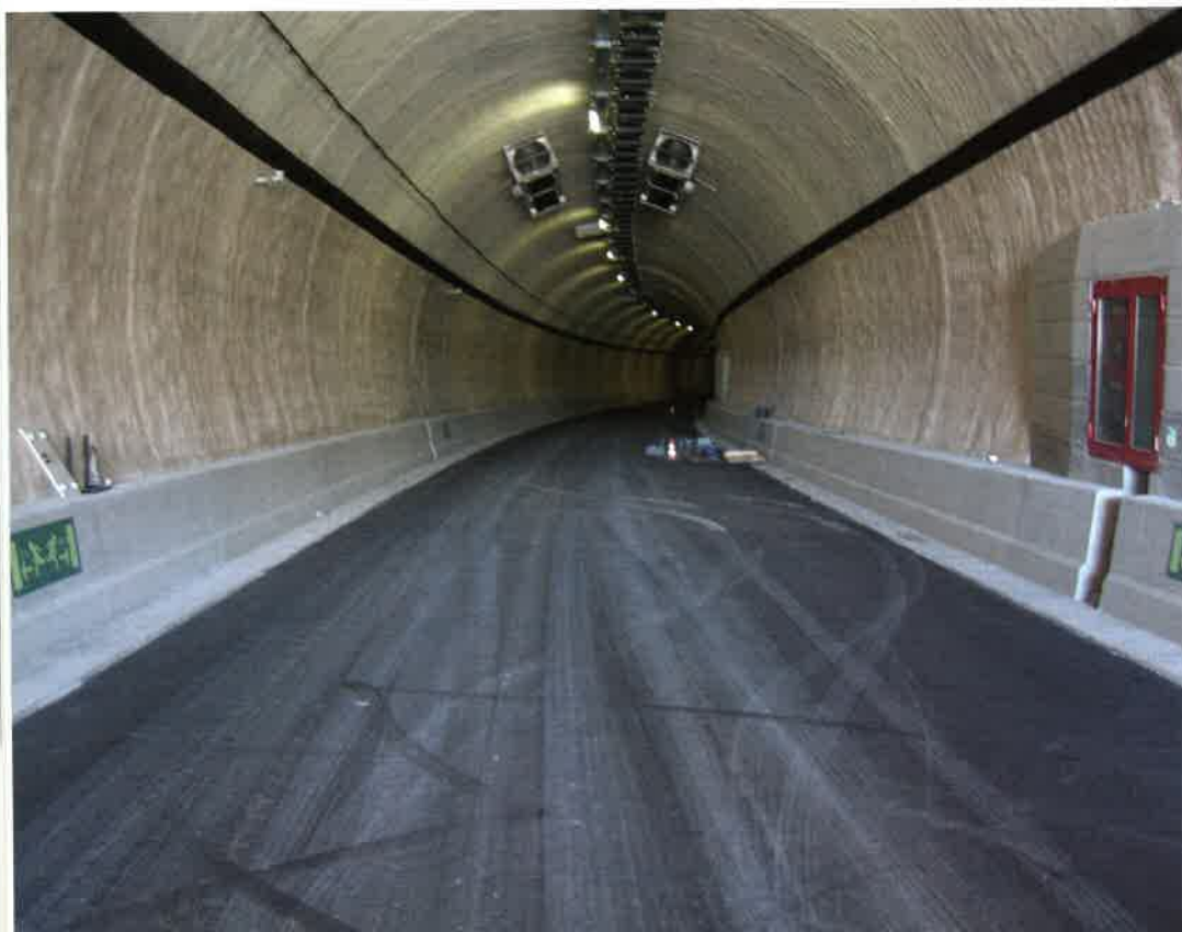
3 | Installaties en hulpposten verhogen veiligheid tunnel
